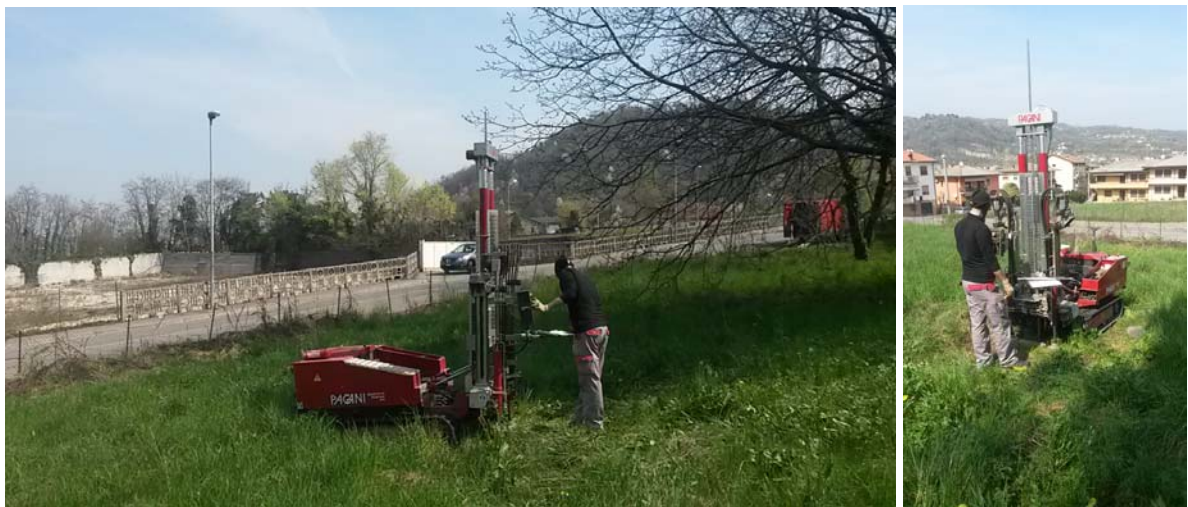
Esecuzione indagini DPSH
